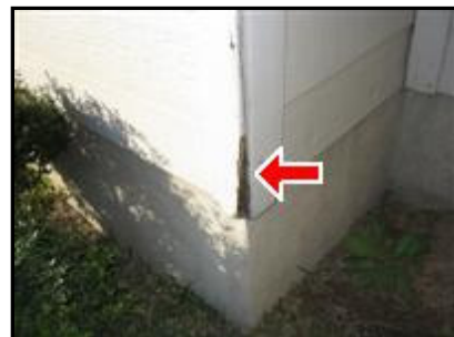
E. Picture 18 Lower edge of chimney
